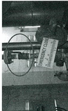
3.10 Check Main Valve Supply NG ต้องอยู่ Open
