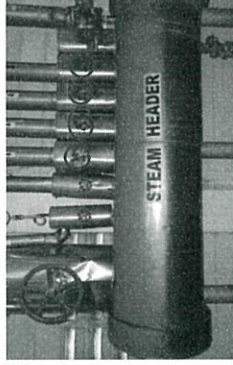
3.16 เปิด Valve Steam Supply เข้า Steam Hc 3.17 เปิด Valve Steam Supply เพื่อใช้งาน (เป็น Valve ของ Boiler No.1,2,3,4)
